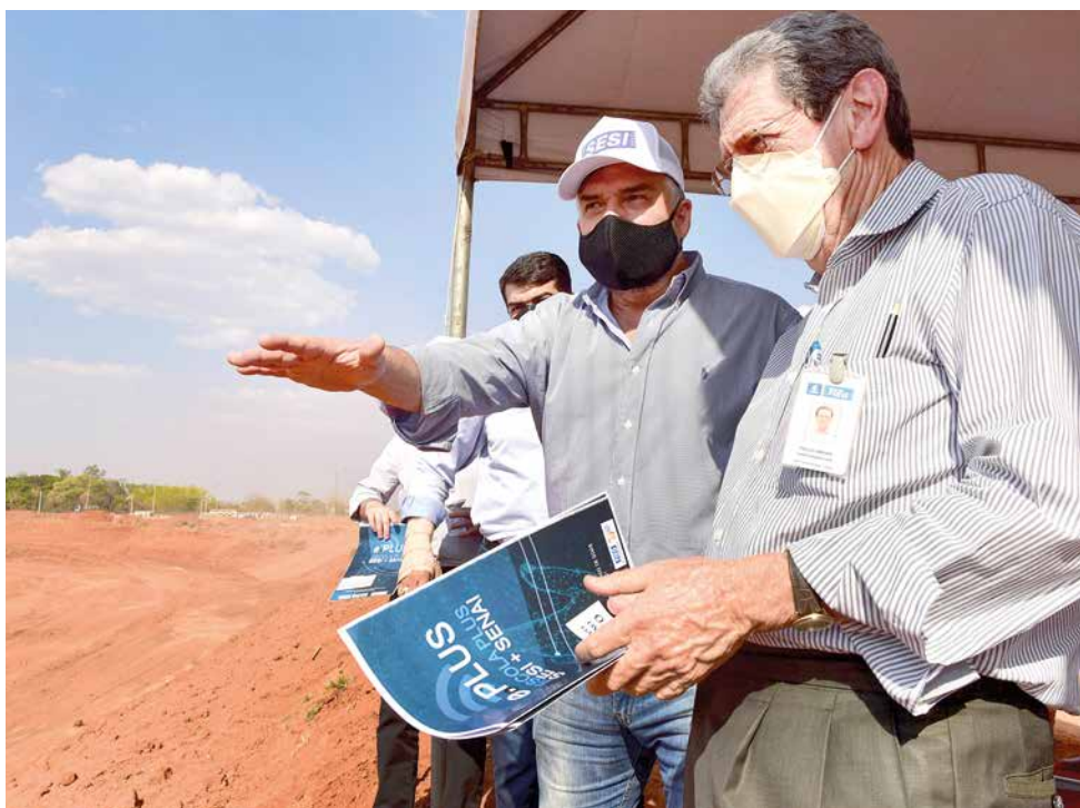
► Sandro Mabel, Paulo Vargas e diretores da Fieg visitam obras de construção da Escola Sesi Senai Plus: centro de excelência em ensino fundamental e médio
