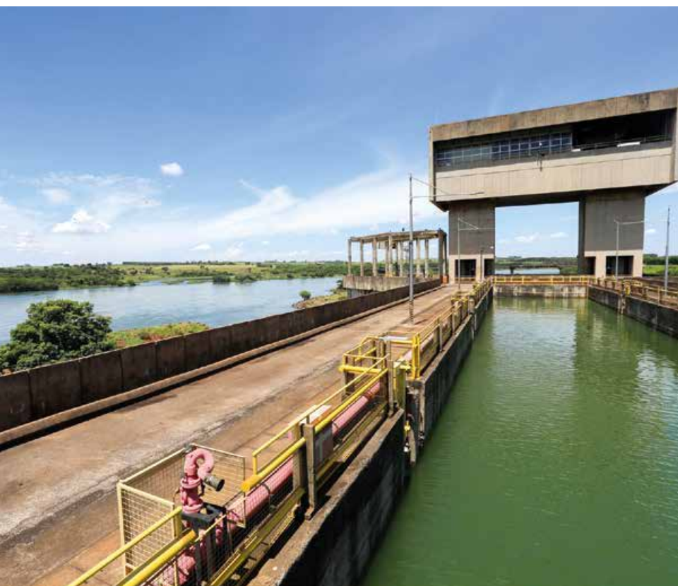
● Eclusa em Nova Avanhandava: obras de derrocamento do canal da usina deverão estar concluídas até julho de 2019, num investimento de R$ 203,0 milhões
