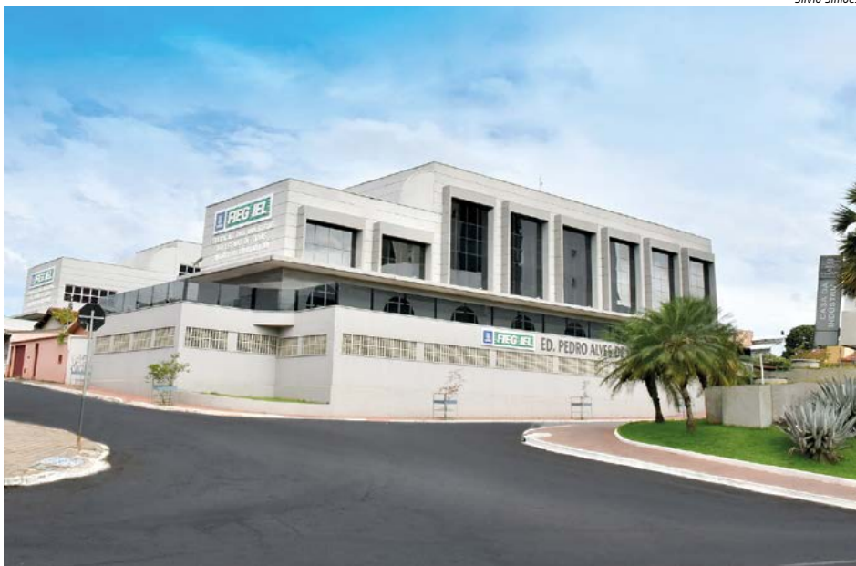
● Edifício Pedro Alves de Oliveira: sistema de captação e reuso de água pluvial reduz uso de água tratada em 38%
