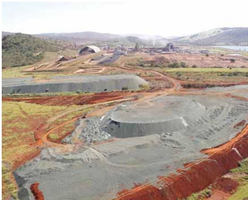
*Rejeitos: material poderá substituir a brita na pavimentação de rodovias e ruas e a areia na produção de blocos de concreto*
