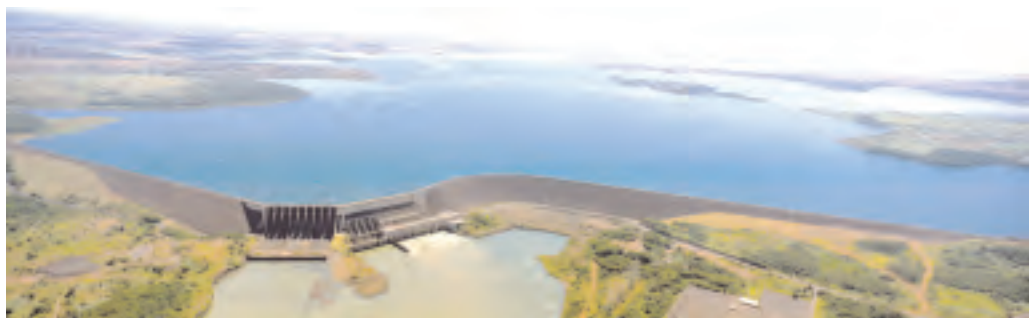
Hidrelétrica de São Simão: concluída em 1978, usina tem potência instalada de 1.710 MW
